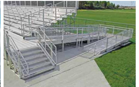
ADA ACCESSIBLE RAMP
